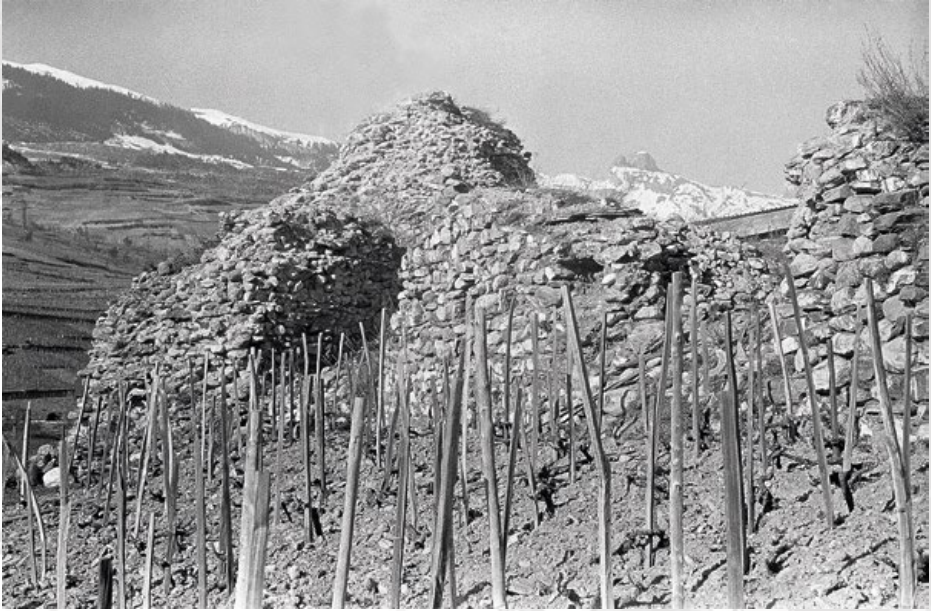
Cinq siècles n'ont pas effacé le paysage l'empreinte du puissant donjon, construit par Pierre II de Savoie en 1260. Sur cette photo prise entre 1930 et 1940, on distingue clairement au sommet de la colline cultivée des murs massifs sur plusieurs dizaines de mètres. Photo : Raymond Schmid, Bourgeoisie de Sion, Médiathèque Valais – Martigny.
